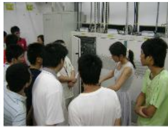
机房现场讲解设备安装
